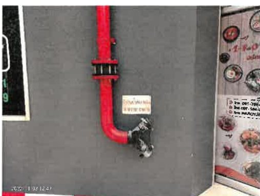
หัวรับน้ำดับเพลิง อาคาร V2 (อาคาร D)
