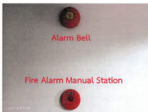
Fire Alarm Manual Station และ Alarm Bell
