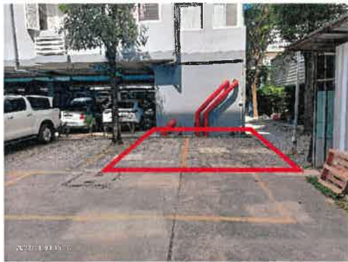
ถังเก็บน้ำดับเพลิงใต้ดิน
